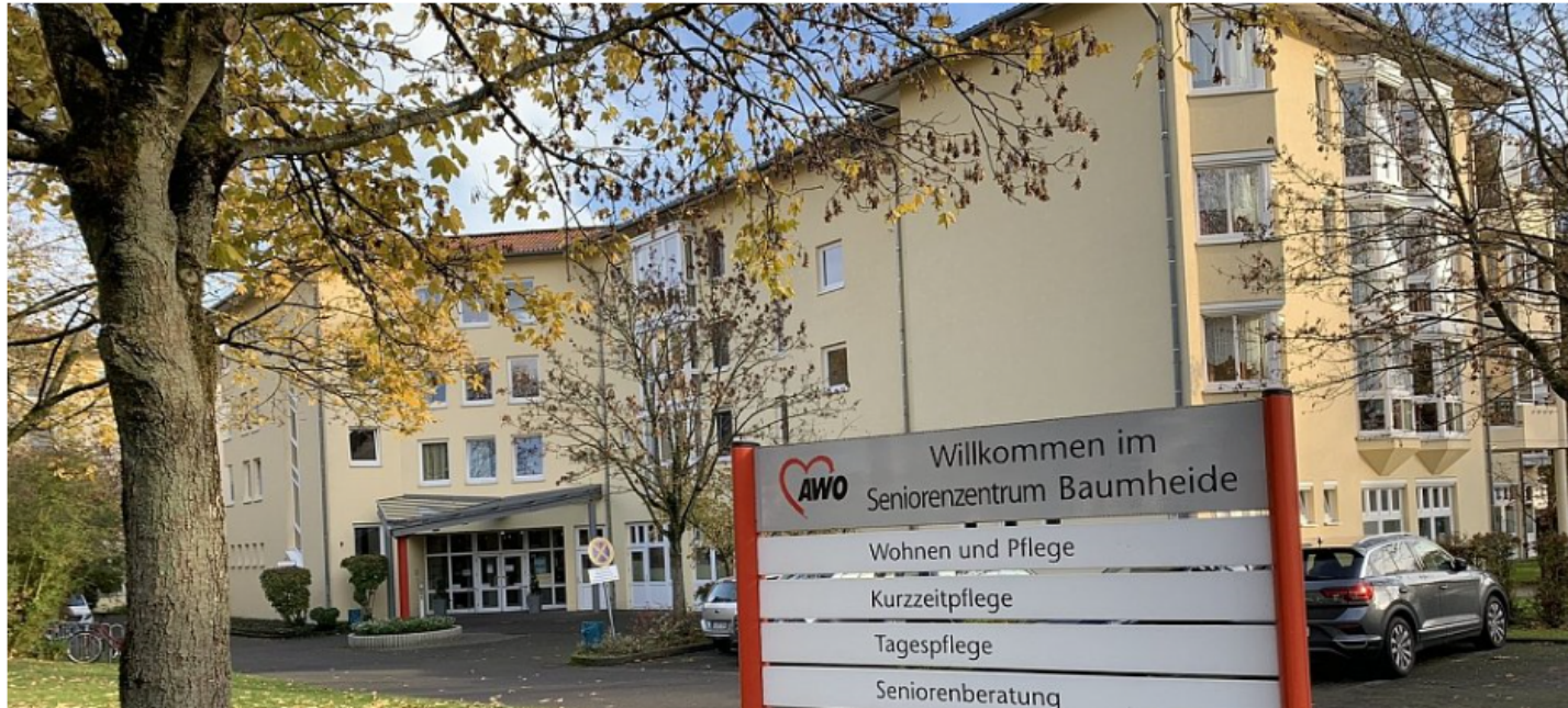
Das AWO Seniorenzentrum Baumheide ist leer und soll saniert werden. | © Stefan Becker
