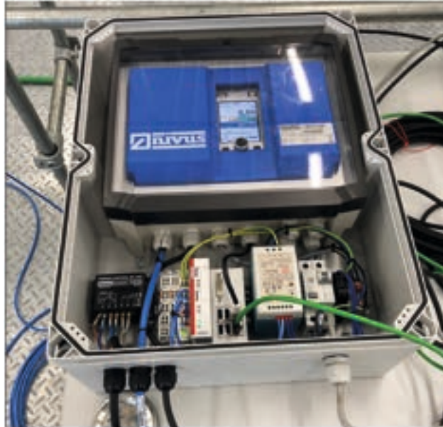
Abb 1: Wasserdichtes Leergehäuse mit dem Durchflussmessgerät NivoFlow 750 und der Steuerungstechnik unten im Bild
