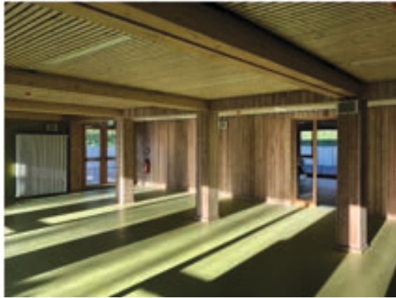
Abb. 1: Beispiel eines Holzmodulgebäudes
